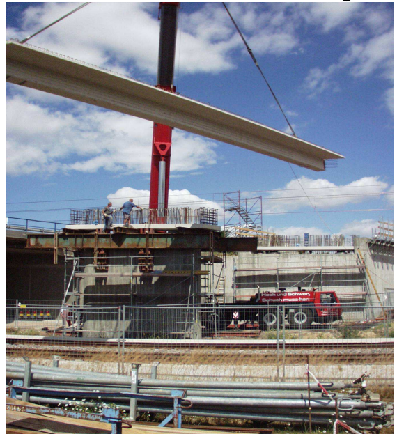
Bau Wirtschaftswegebrücke Hoffentlich passt's !
